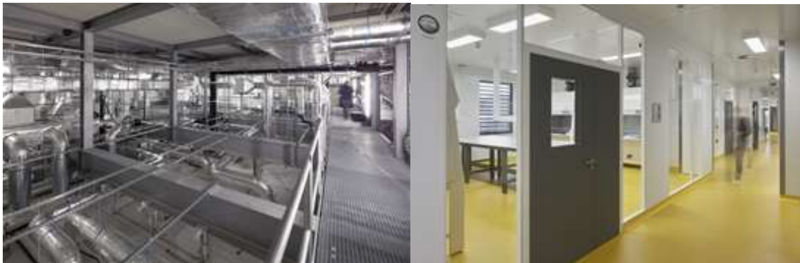
Figuur 30 - voorbeeld van een beloopbaar plafond boven cleanrooms. Figuur 31 - voorbeeld van cleanroom
